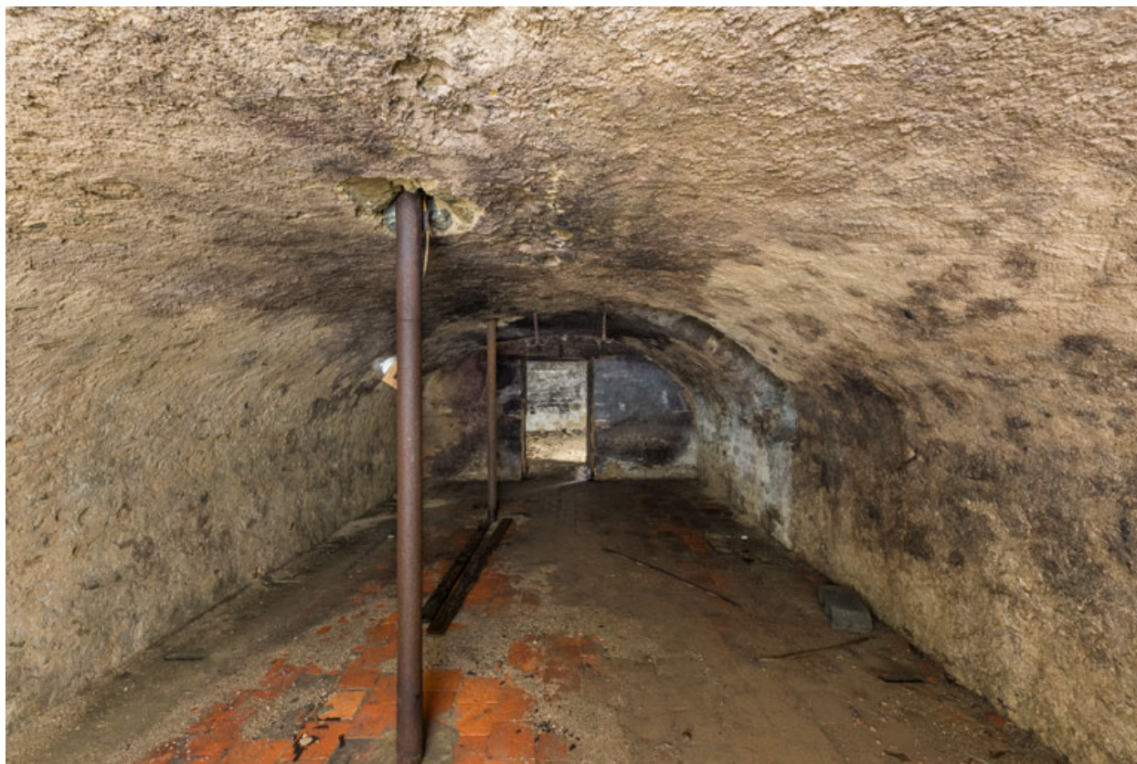
Cave voûtée sous la salle.
