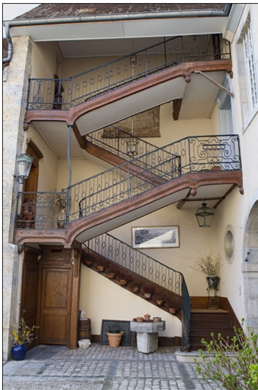
Vue d'ensemble de l'escalier à cage ouverte.
