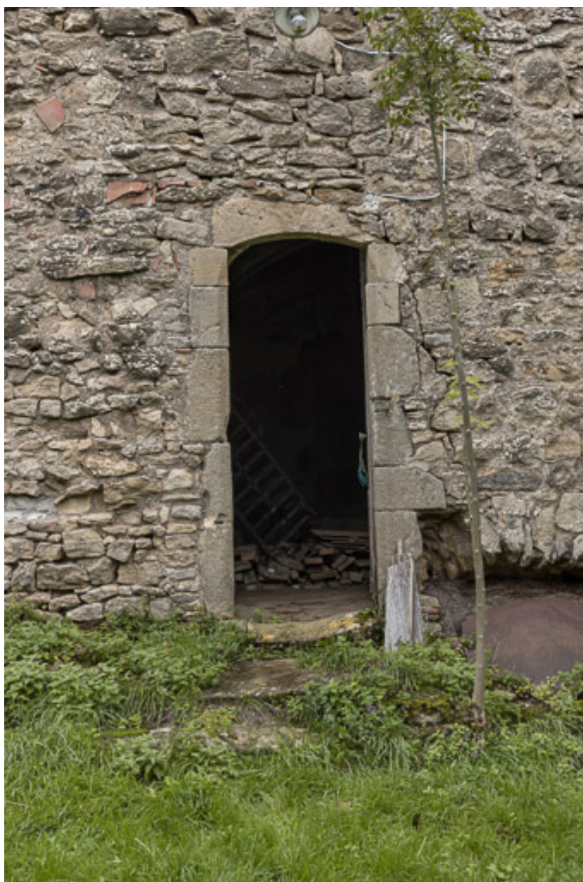
Porte d'accès au rez-de-chaussée de la tour
