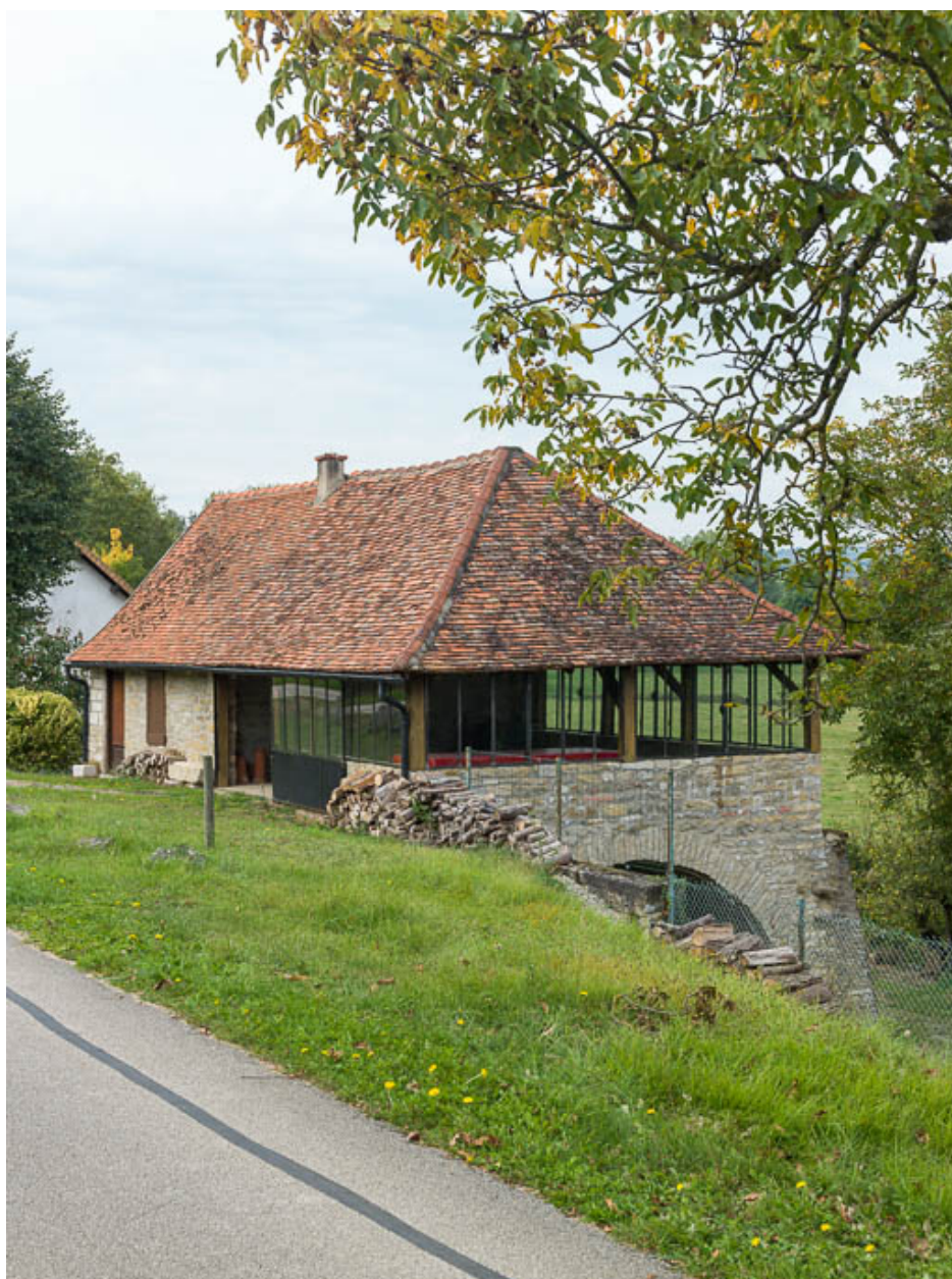
Vue du bâtiment situé en aval.
