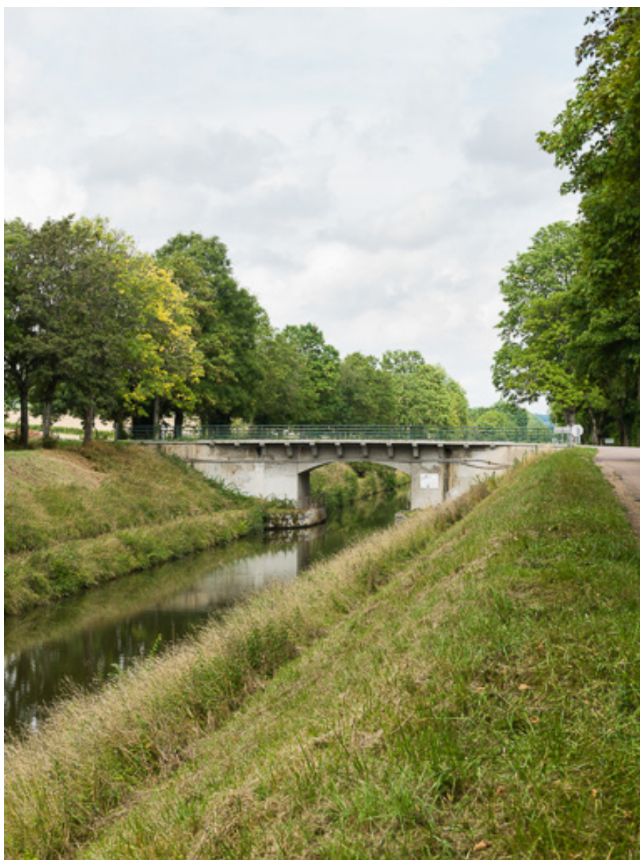
Vue d'ensemble du pont.
