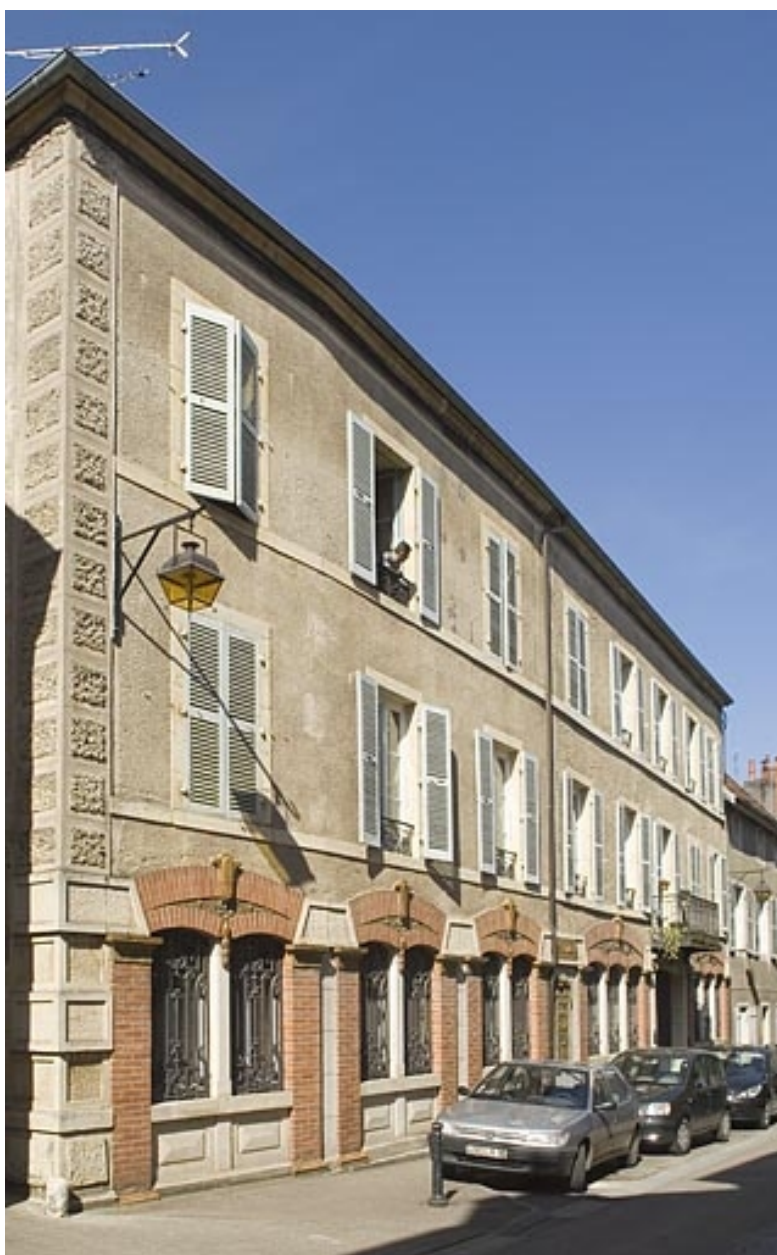
Façade antérieure vue de trois quarts droite.
