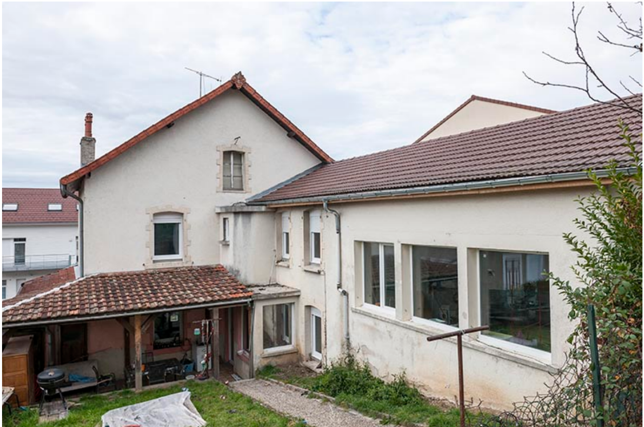
Logement (façade postérieure) et atelier.
