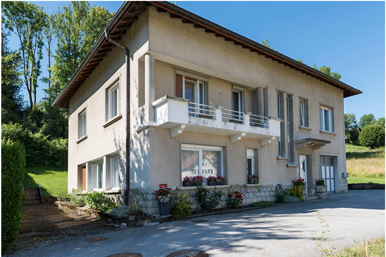
Façades antérieure et latérale gauche.
