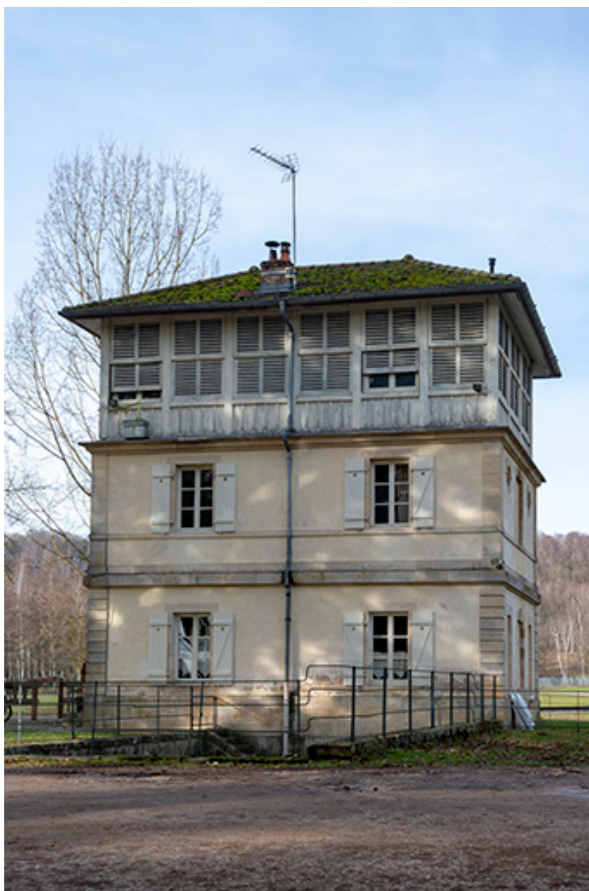
Façade sud-ouest et façade nord-ouest.
