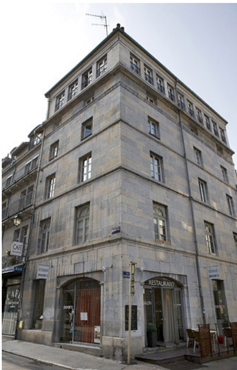
Vue d'ensemble de l'immeuble d'angle.
