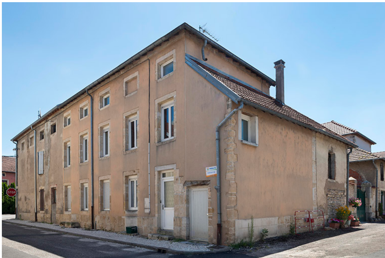
Élévation extérieure sur la rue des Fours.
