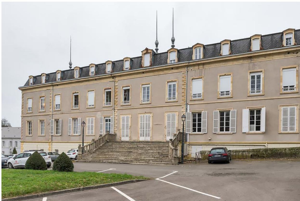
Aile nord, façade.
