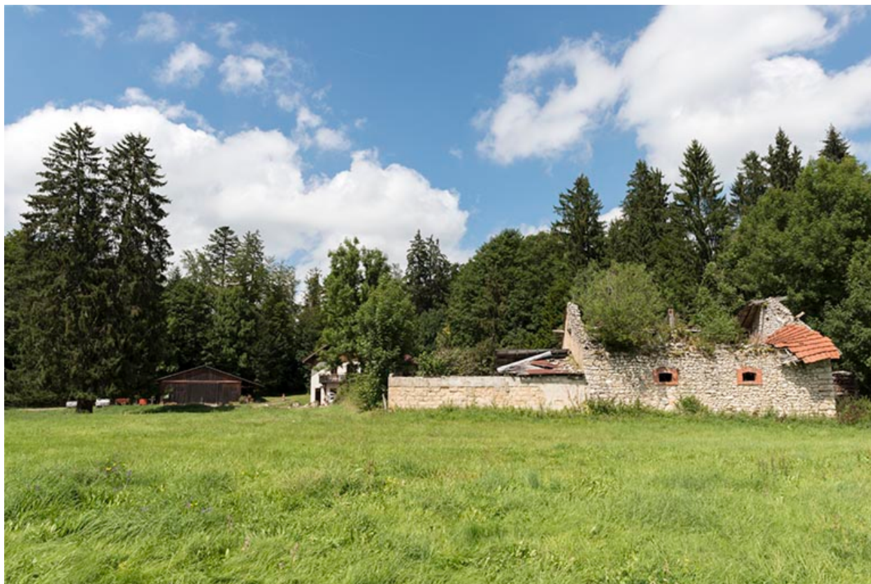
Vestiges de la porcherie, depuis le sud.
