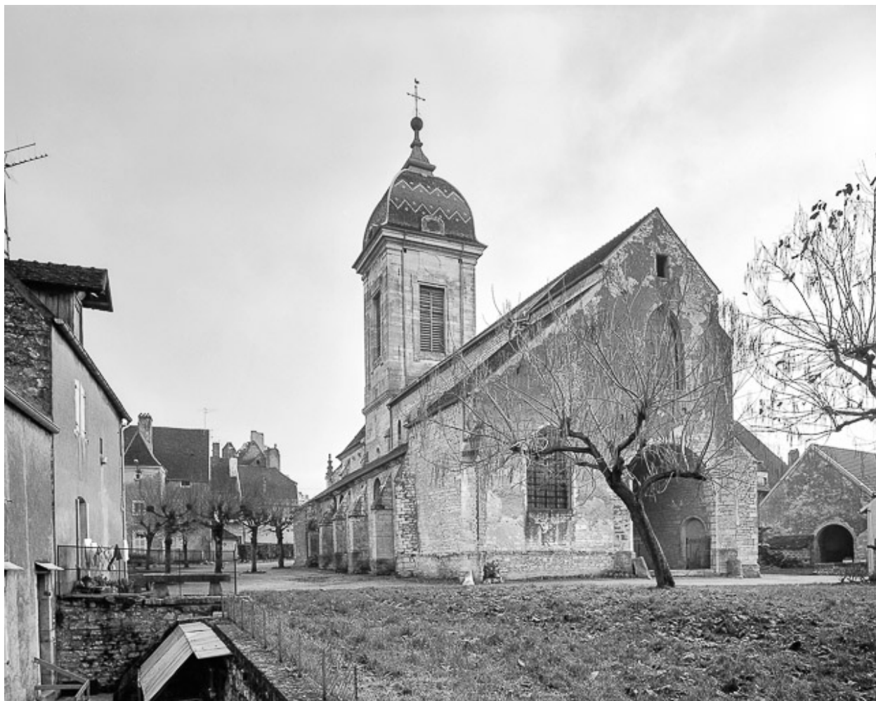
Exérieur : façade ouest.
