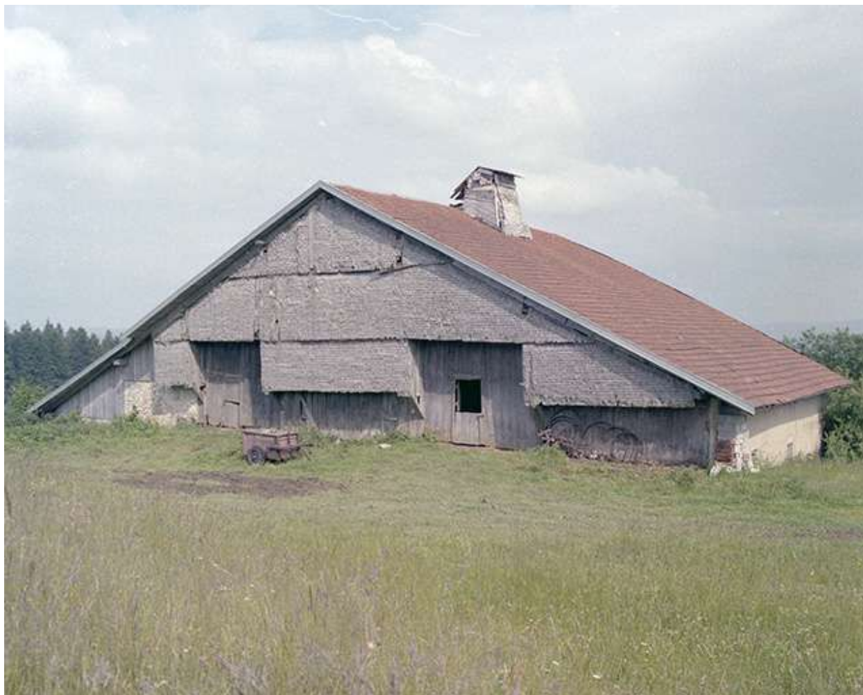
Façades postérieure et latérale gauche.
