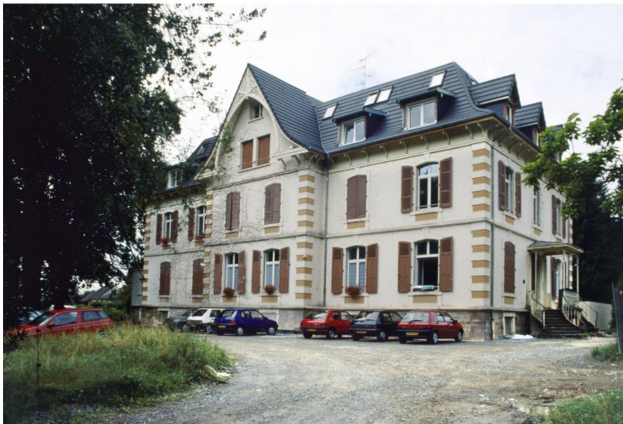
Logement patronal vu de trois quarts.
