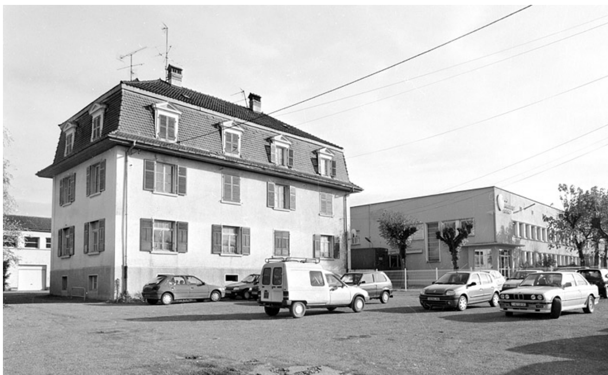
Logement (anciens bureaux) et atelier de fabrication.
