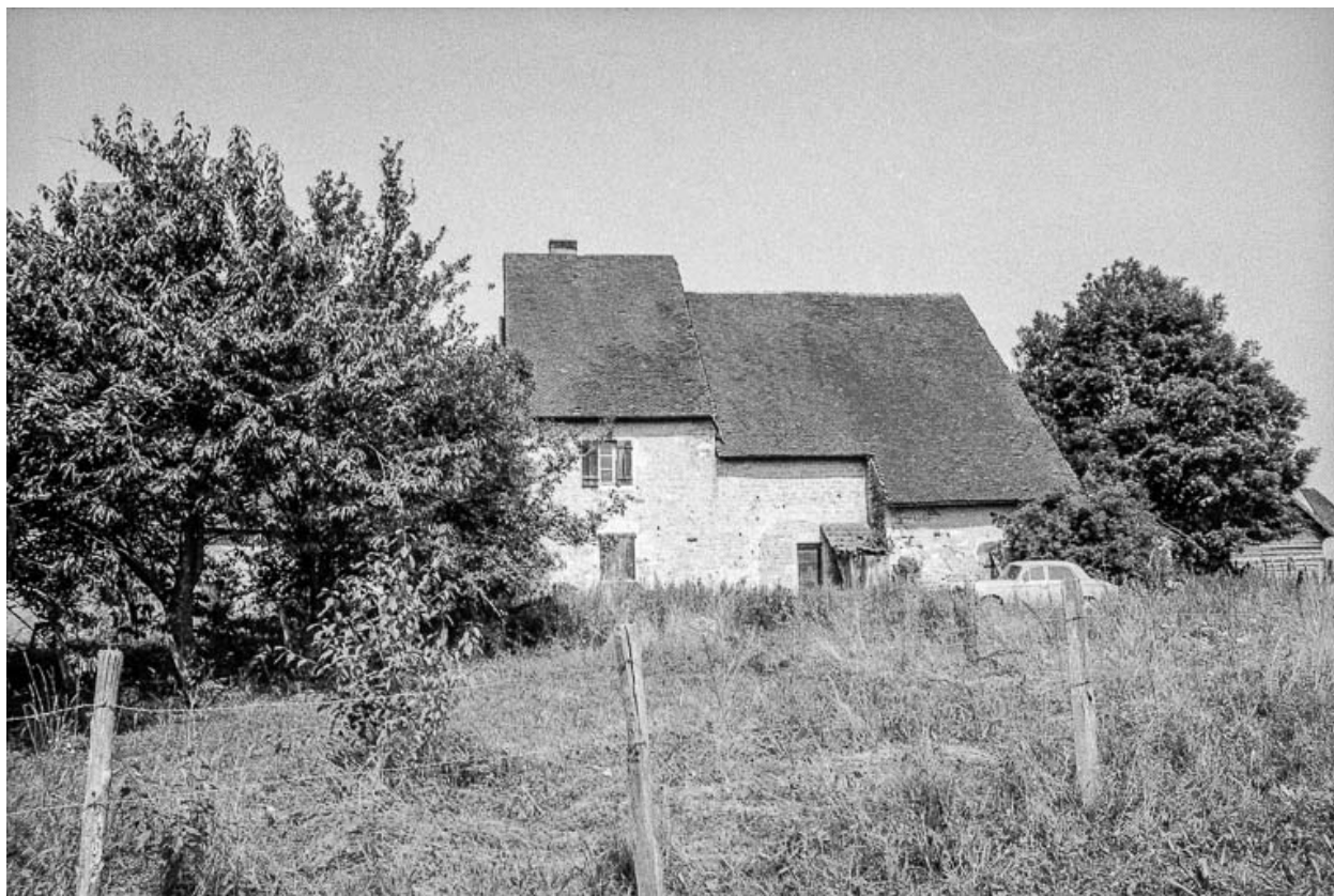
Façade postérieure en 1975.
