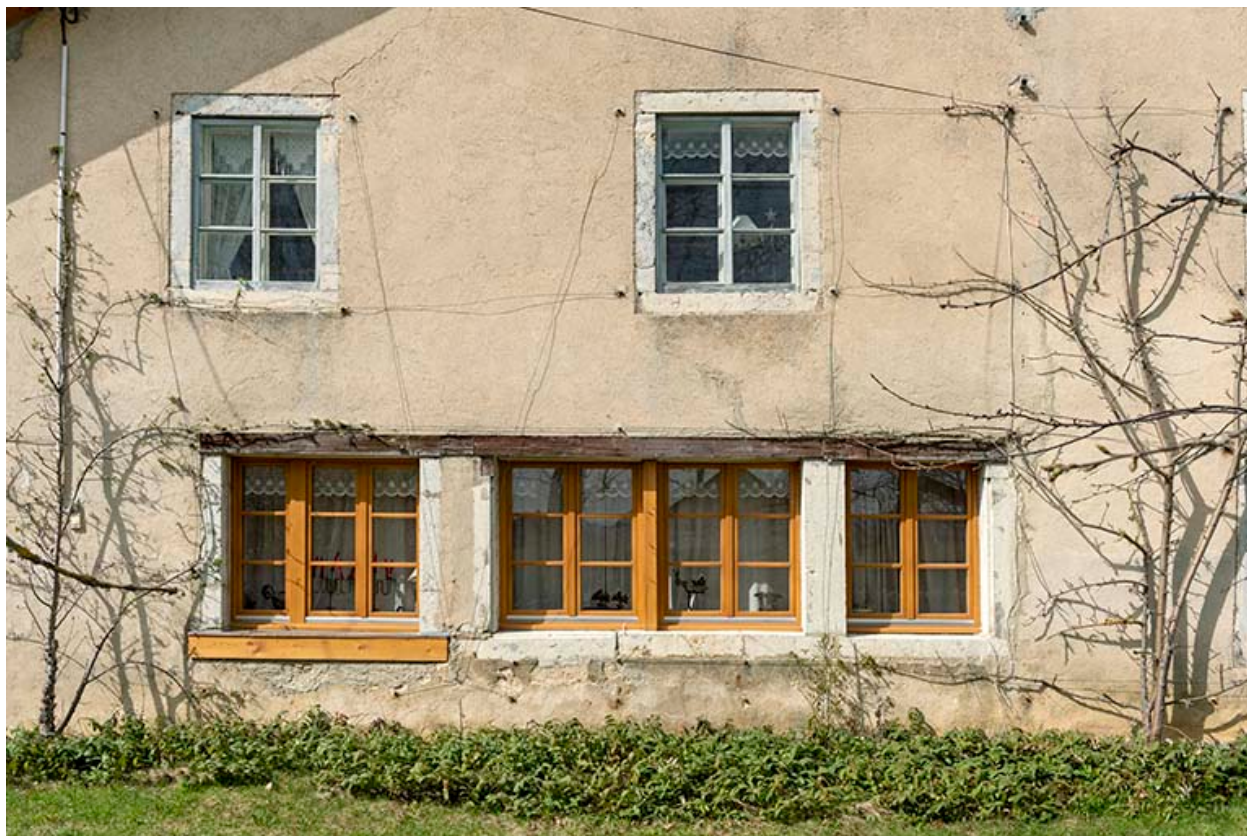
Façade sud : fenêtre multiple de l'atelier.
