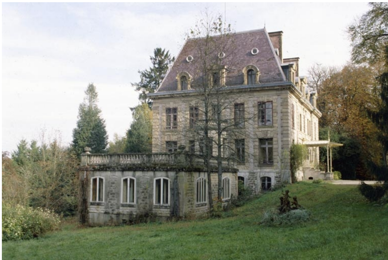
Vue depuis l'ouest.
