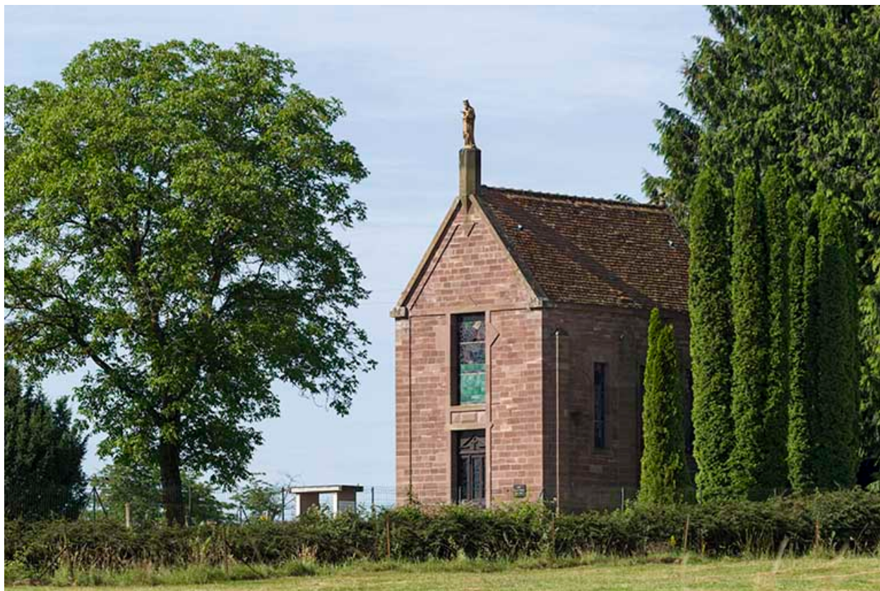
Façade principale de la chapelle.
