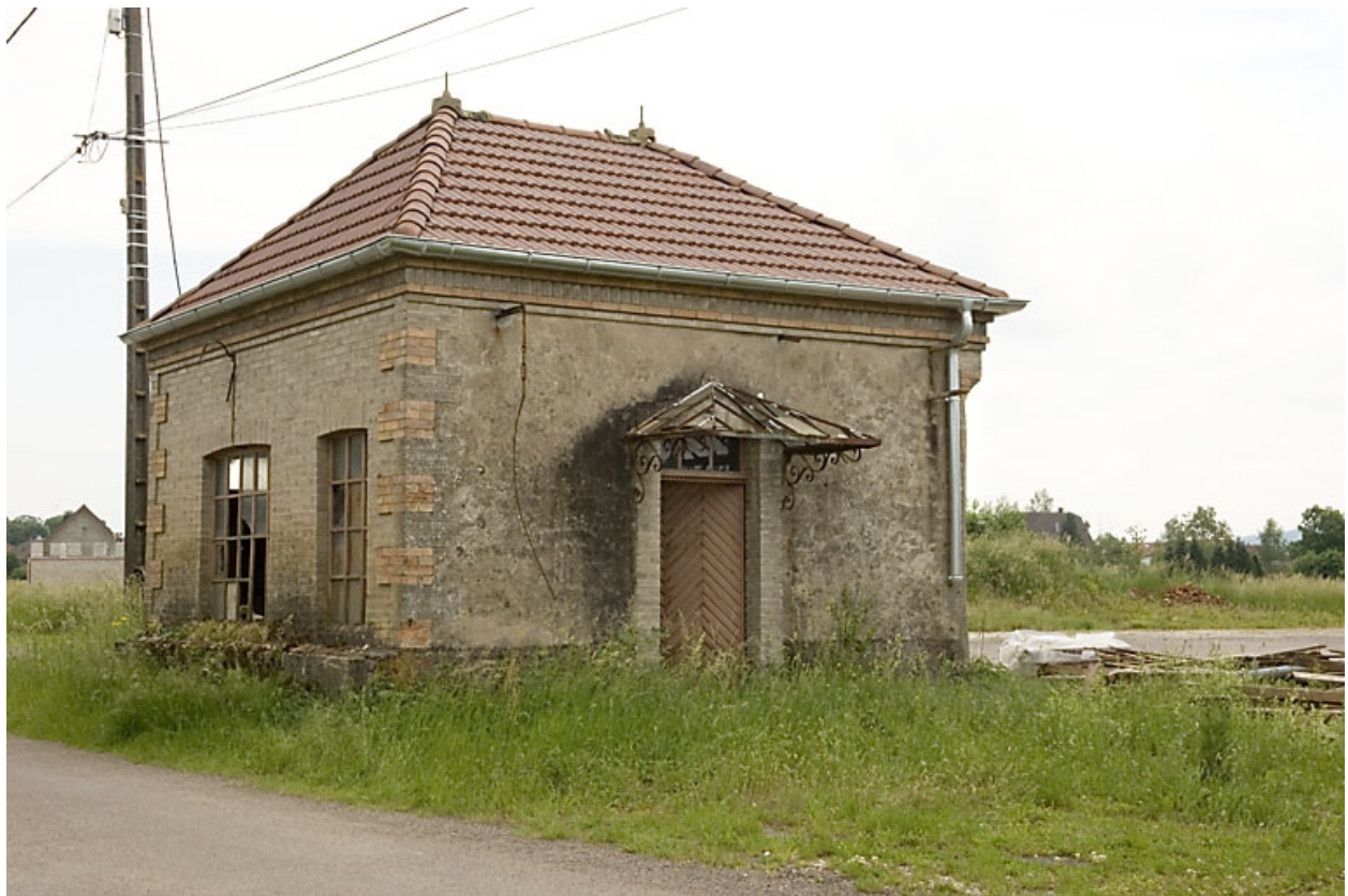
Local de la balance du pont bascule.
