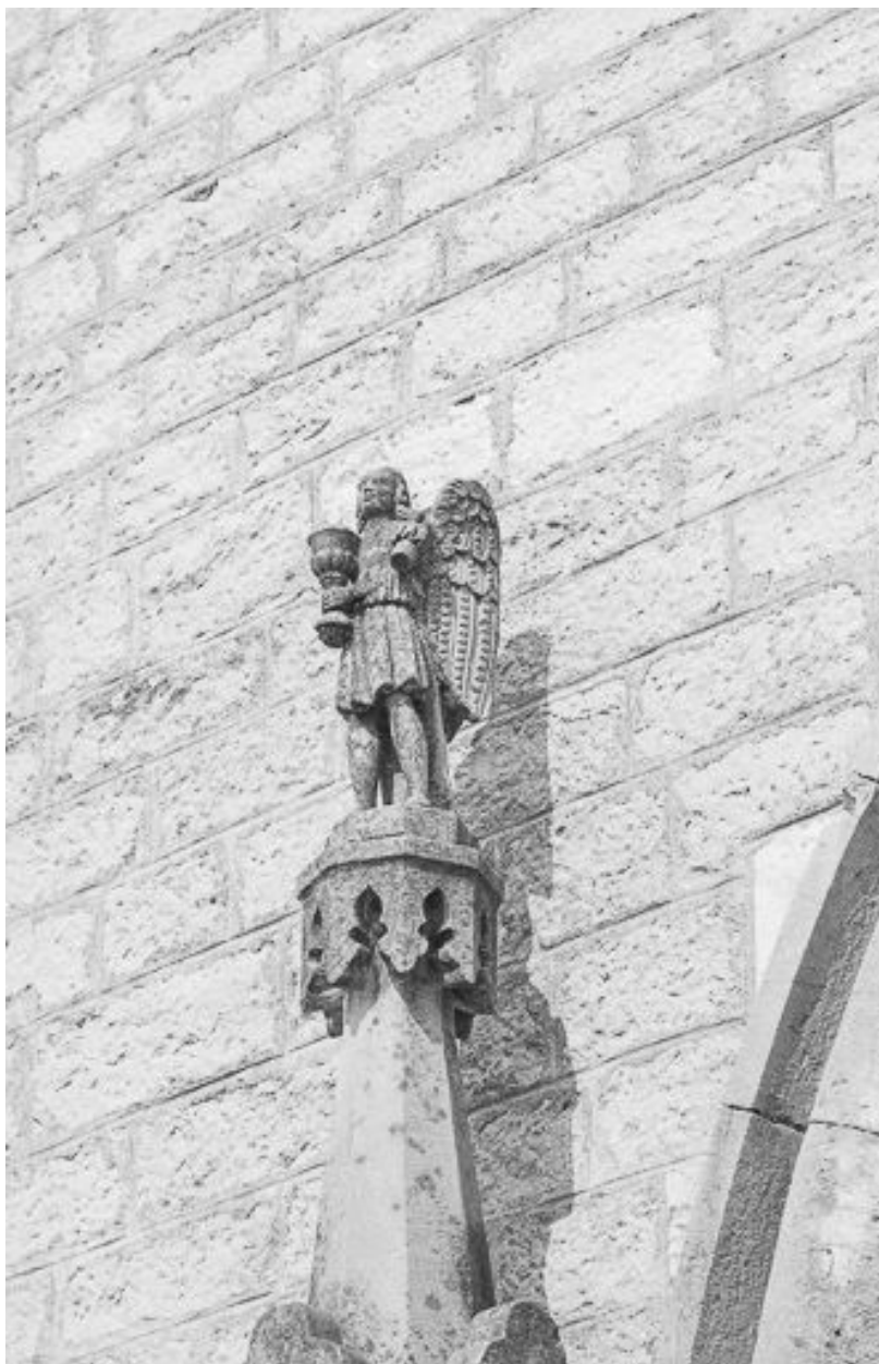
Extérieur : portail, façade antérieure, détail.
