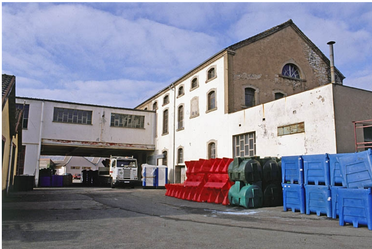
Façade postérieure des ateliers de fabrication.
