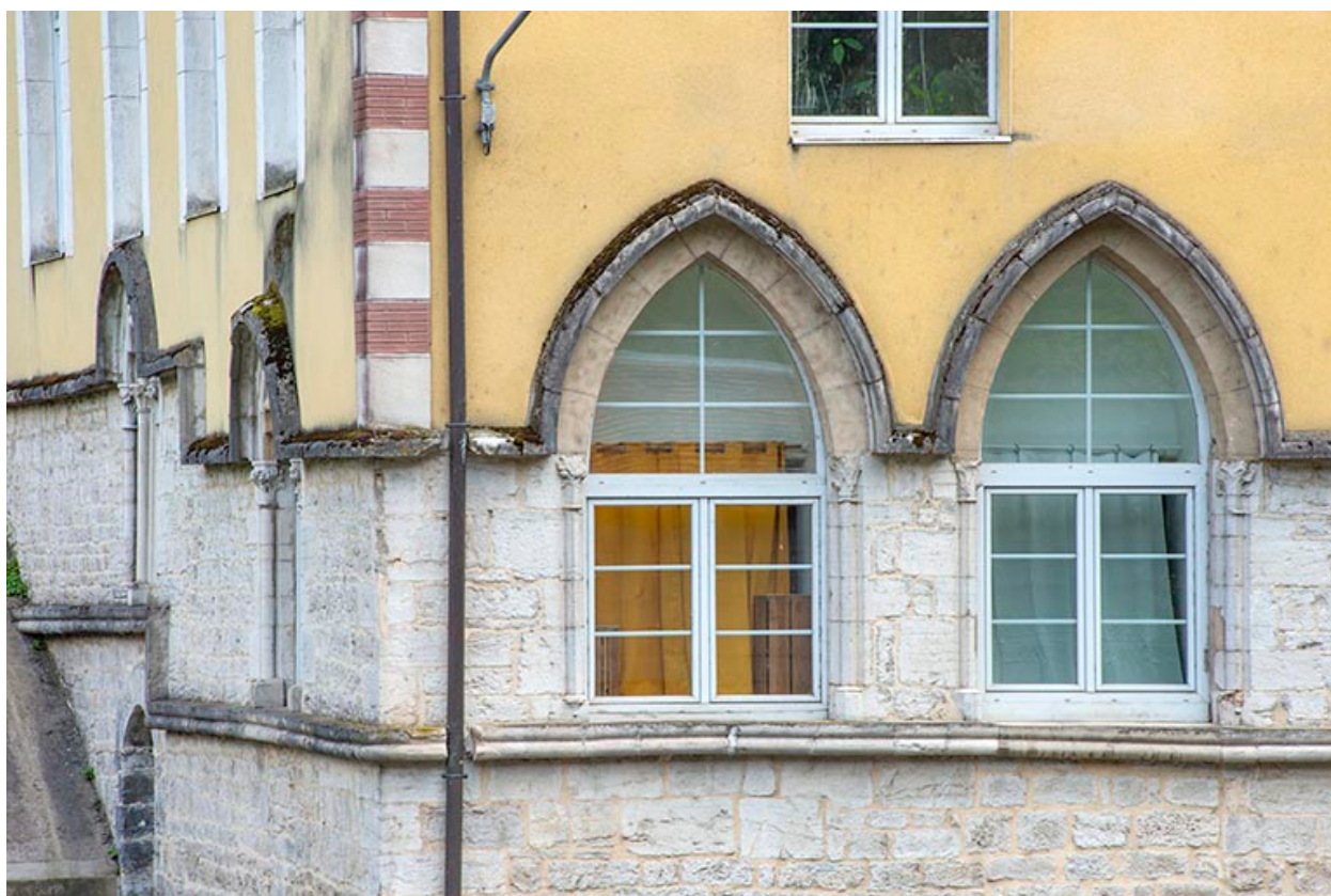
Fenêtres du premier étage, depuis l'ouest.
