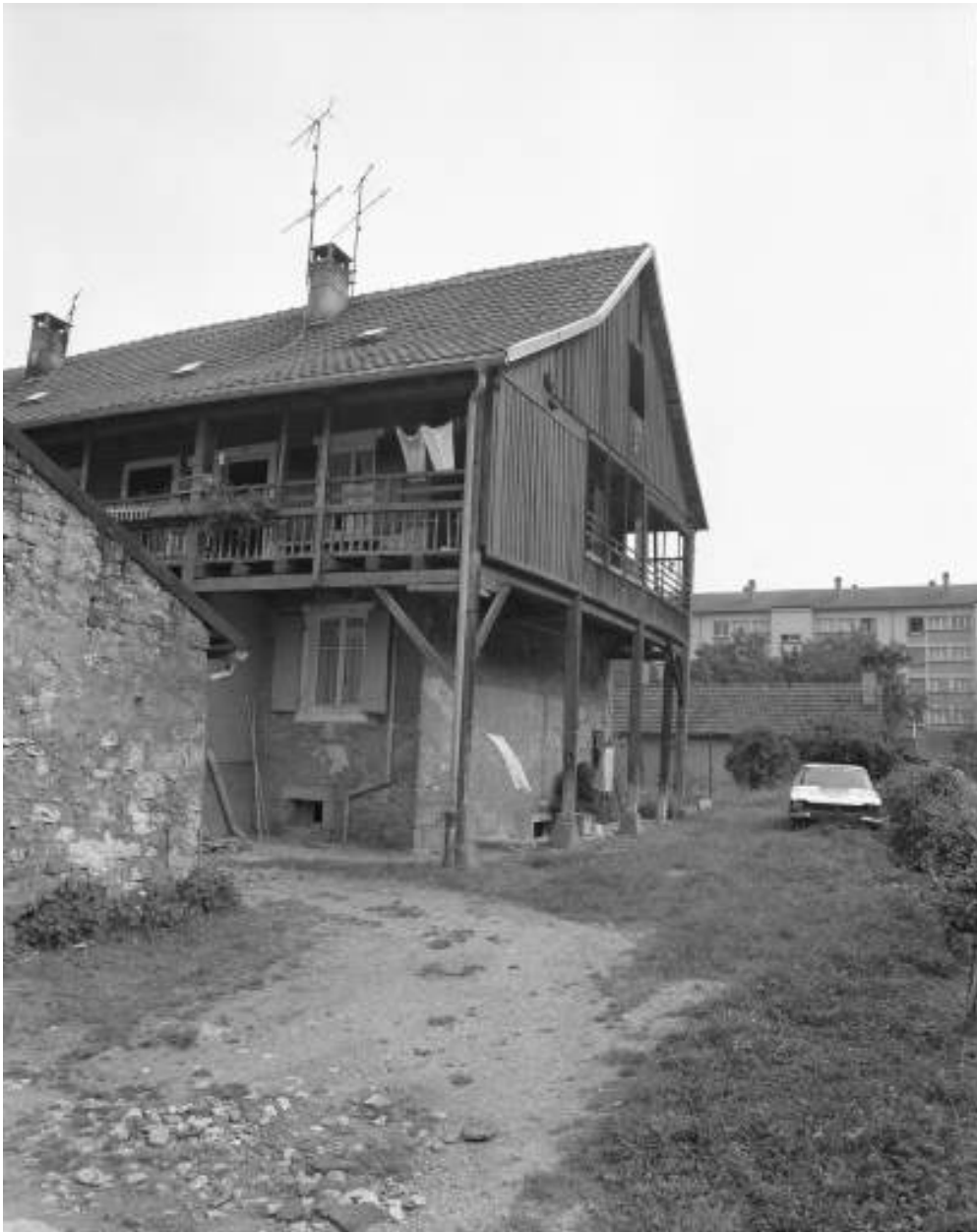
Pignon ouest en 1981.
