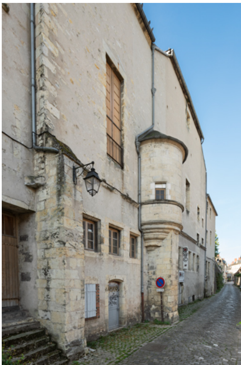
Façade postérieure, vue en enfilade.
