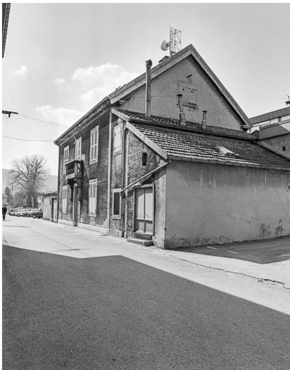
Façades sur rue et latérale droite.
