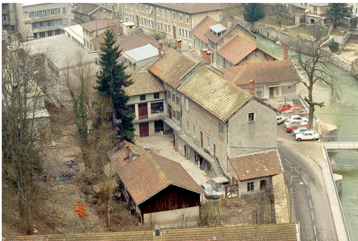
Façades postérieures et latérales gauches.
