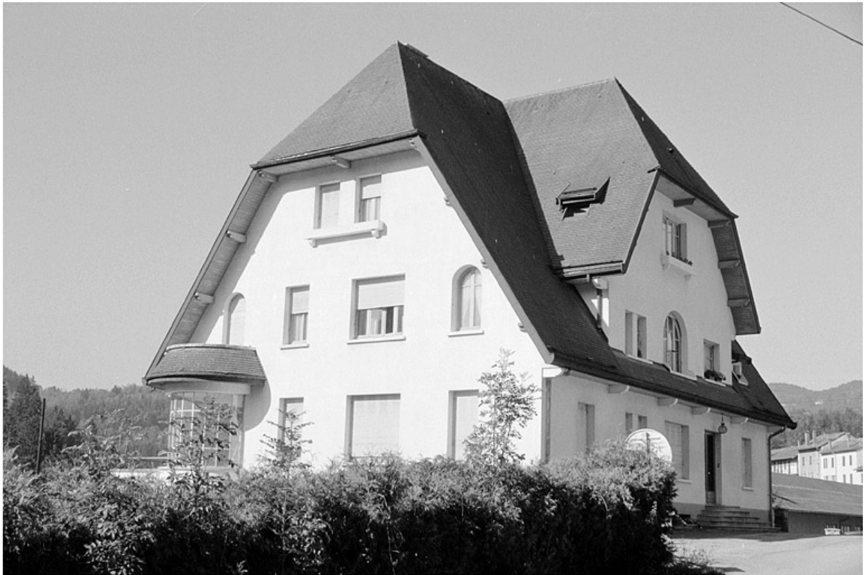
Logement patronal, de trois quarts gauche.
