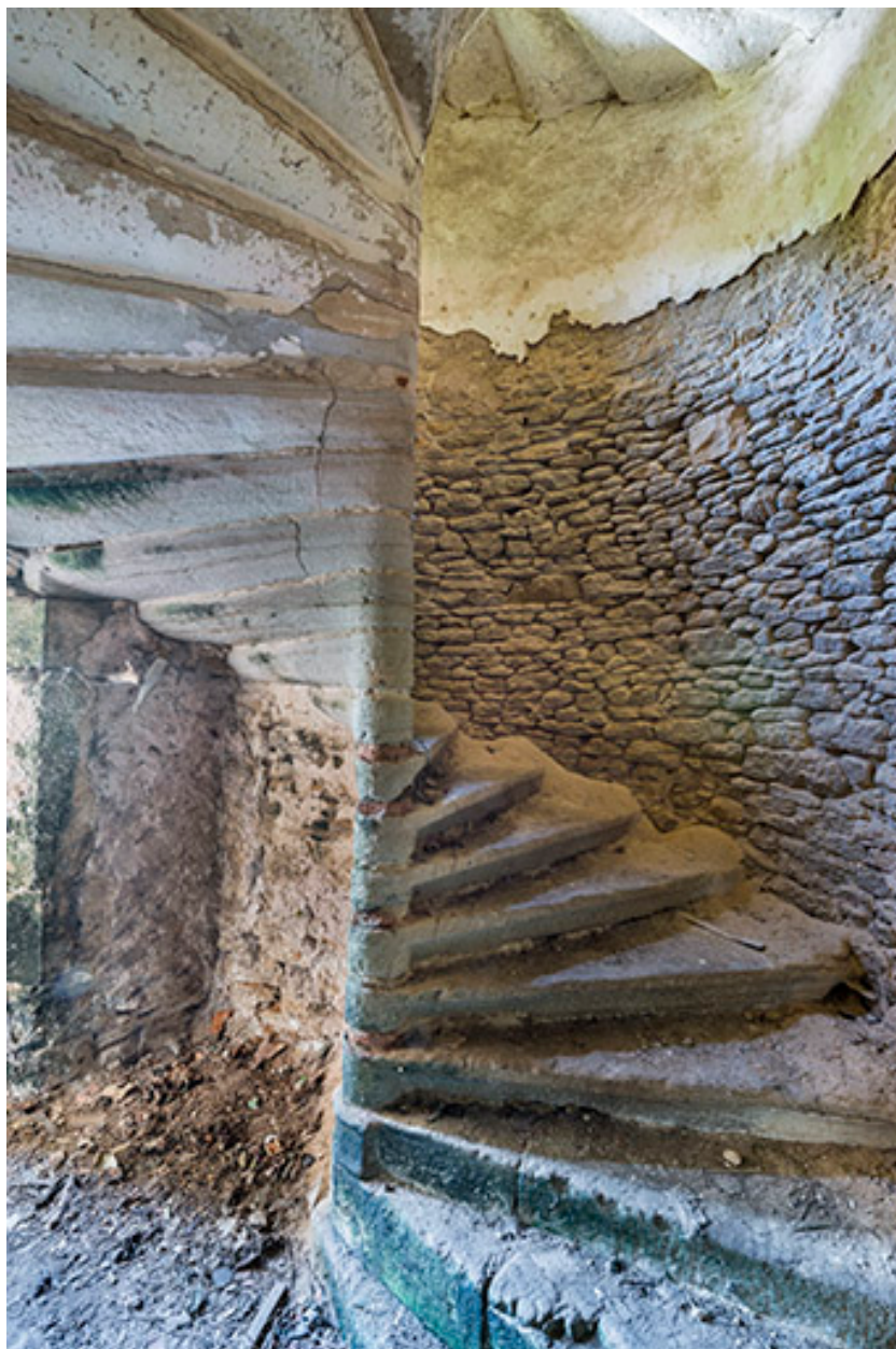
Escalier à vis, rez-de-chaussée du logis 16e siècle.
