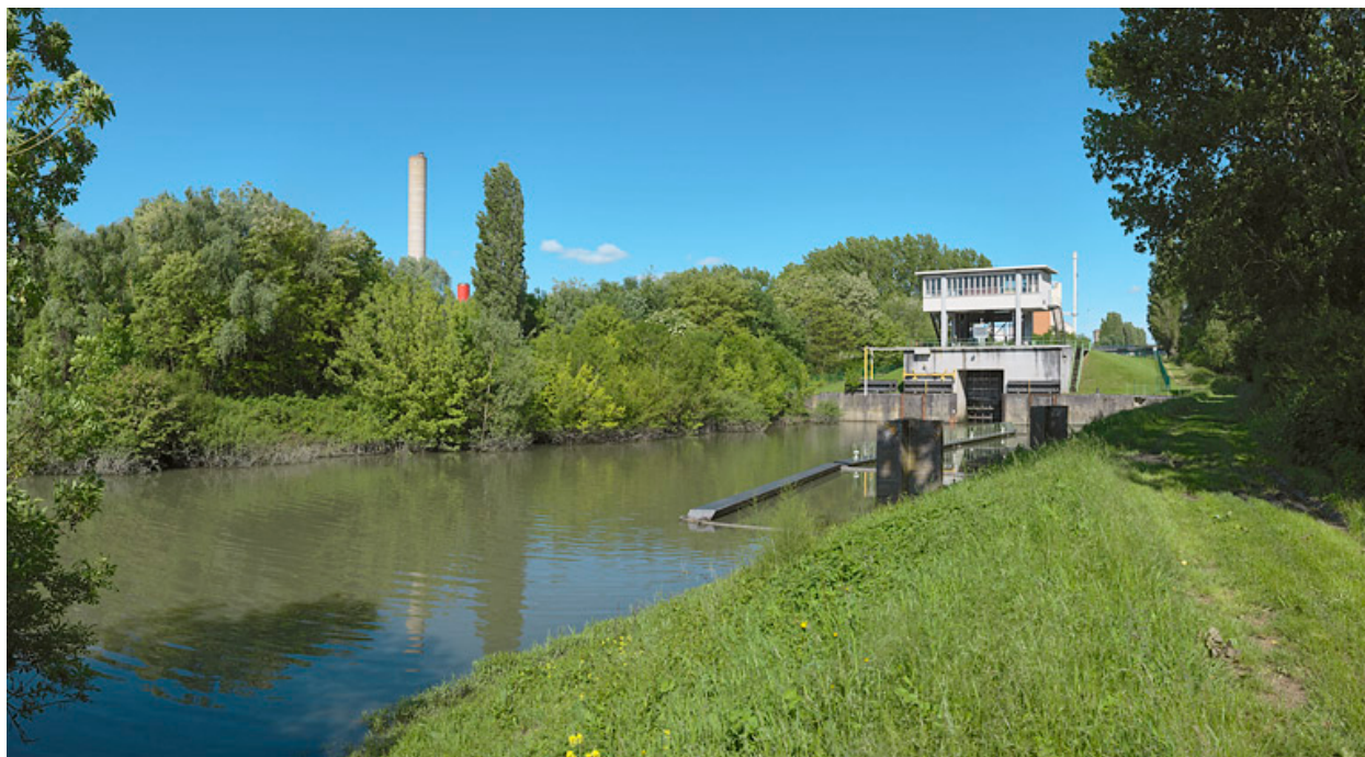
Vue d'ensemble d'aval.
