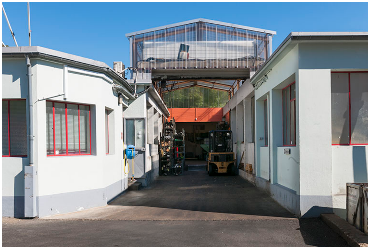
Passage couvert dentre l'atelier originel et son extension (à droite).
