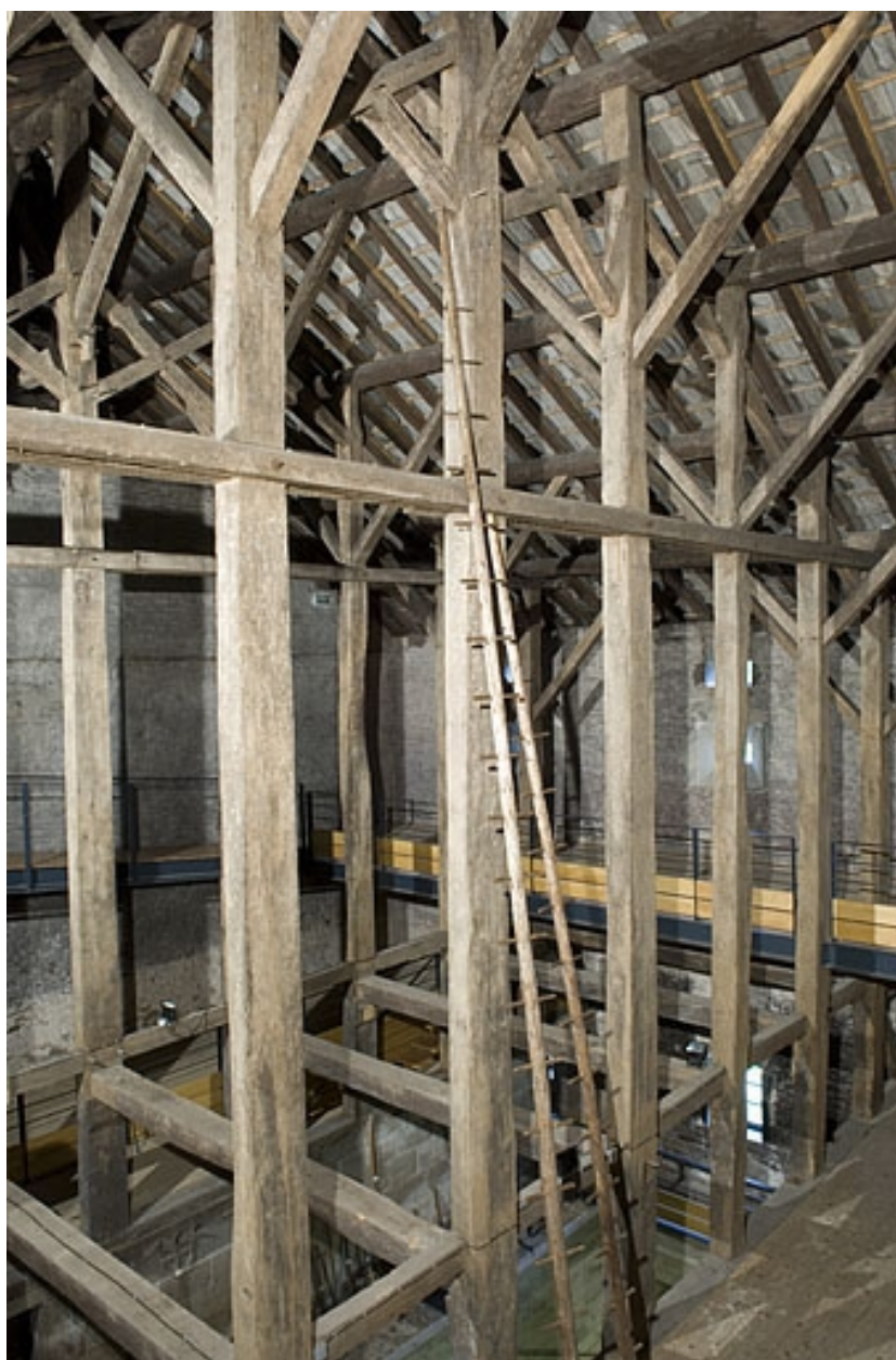
Charpente du fenil (cadrage vertical).
