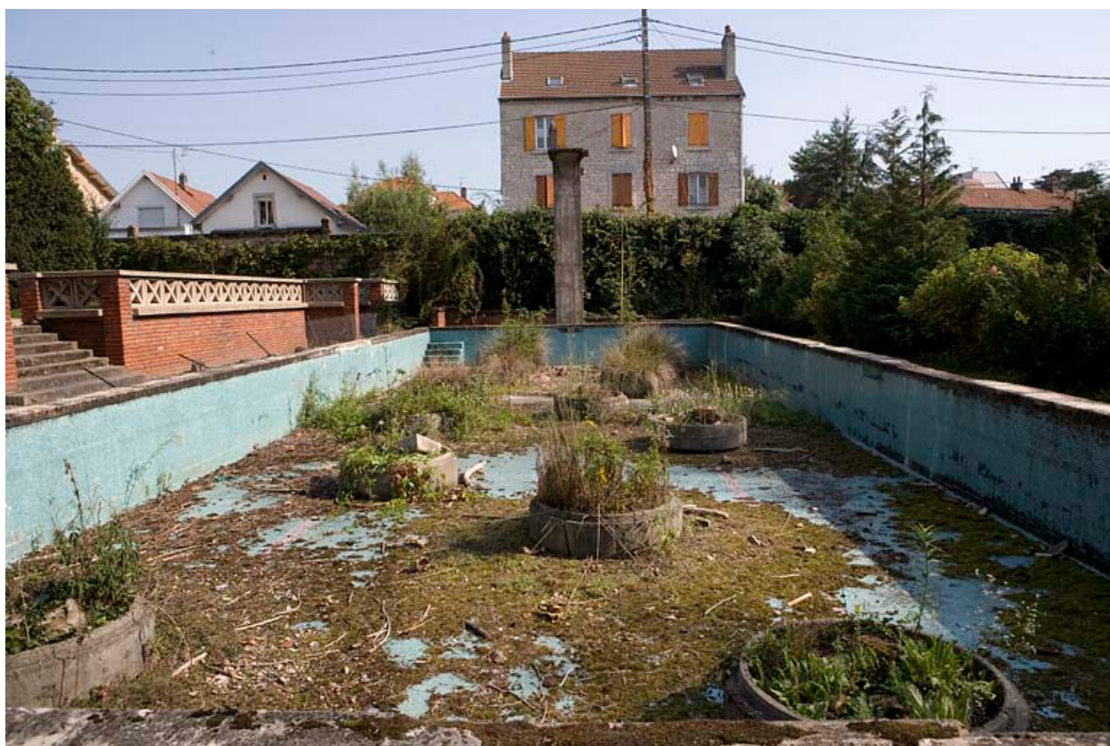
Piscine : le bassin à l'abandon.
