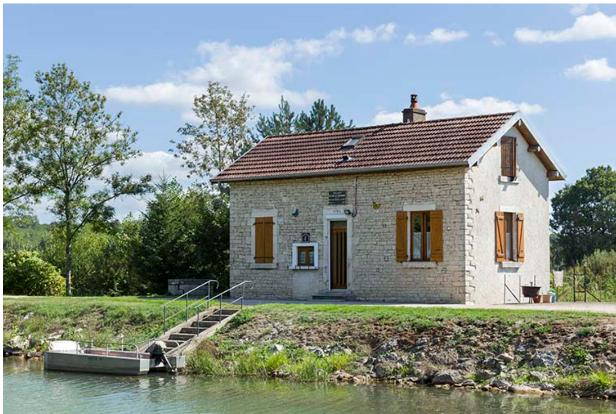
La maison de l'éclusier.
