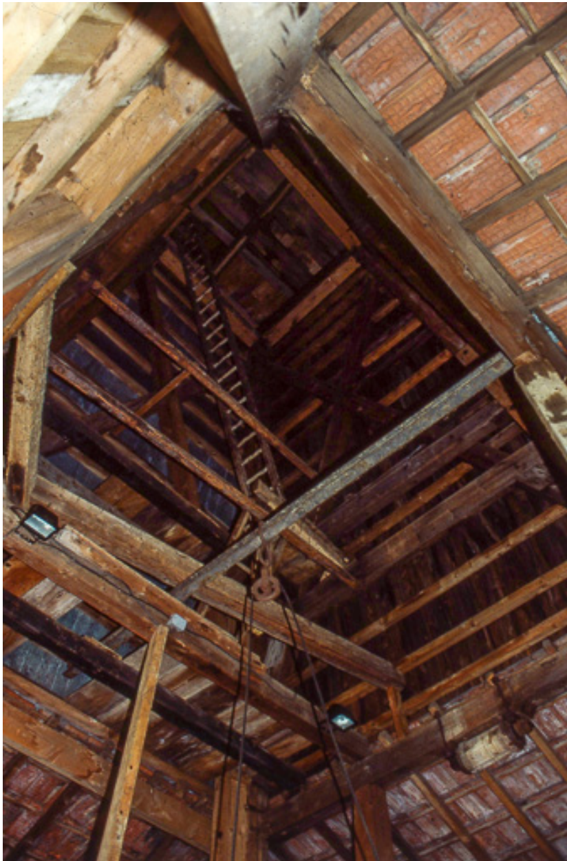
Puits de sondage nord : intérieur
