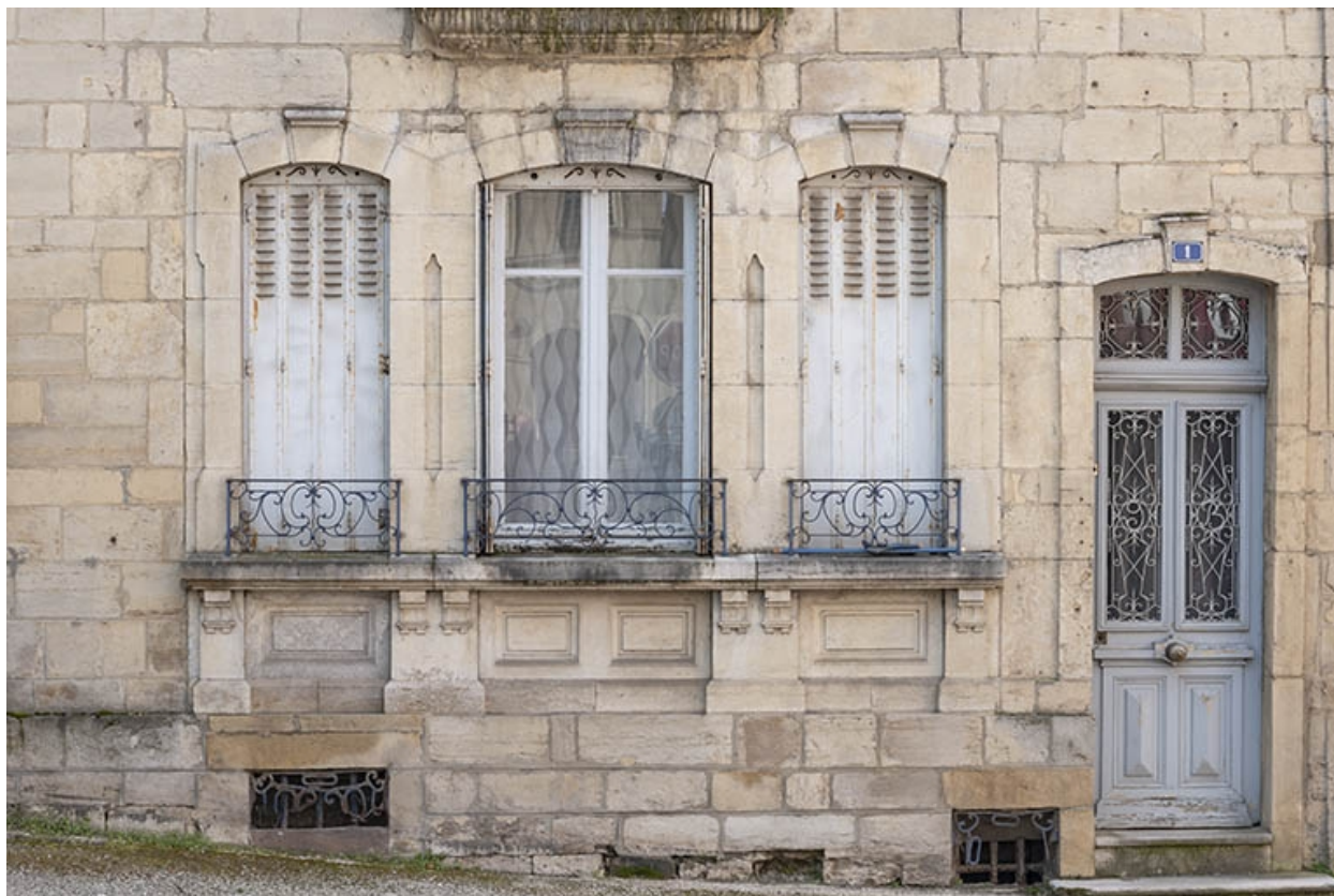
La rue Gambetta : n° 1, rez-de-chaussée.
