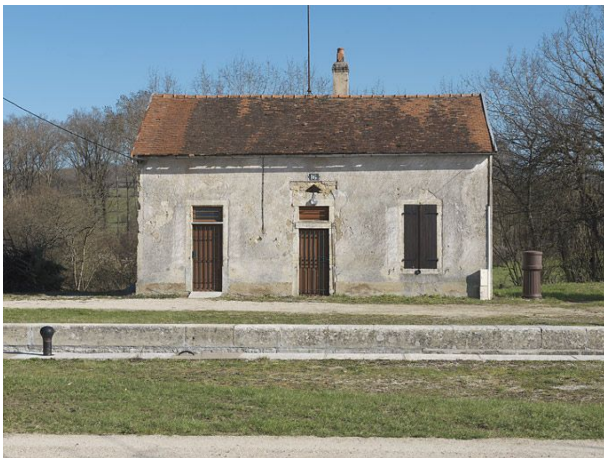
La maison éclusière de face.
