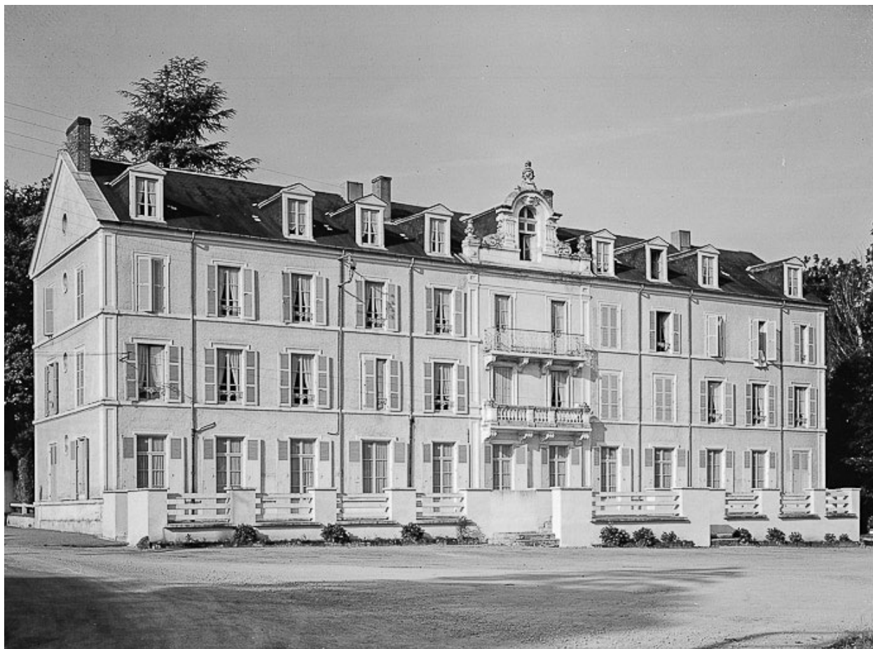
Façade nord du corps principal, vue de 1984.
