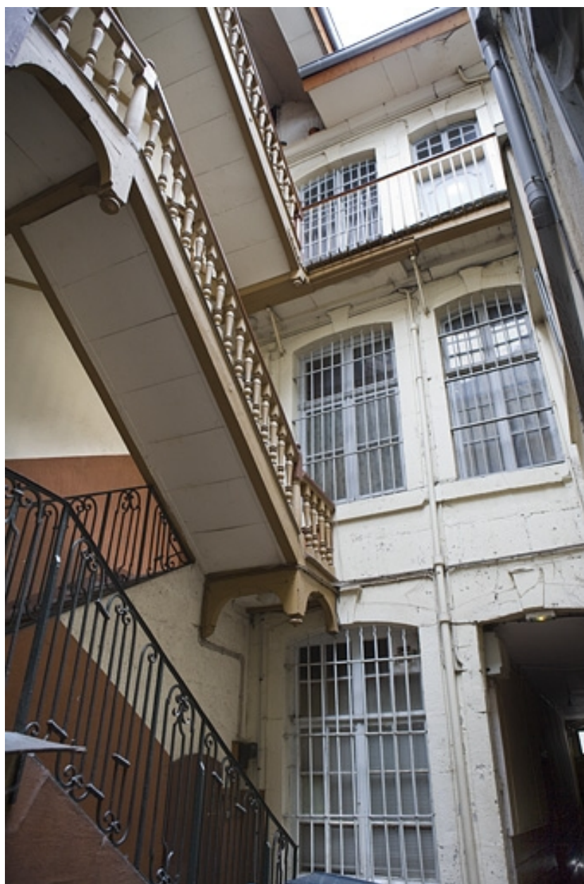
Façade postérieure du logis principal.
