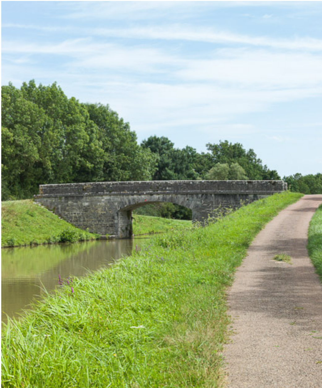
Vue d'ensemble du pont.
