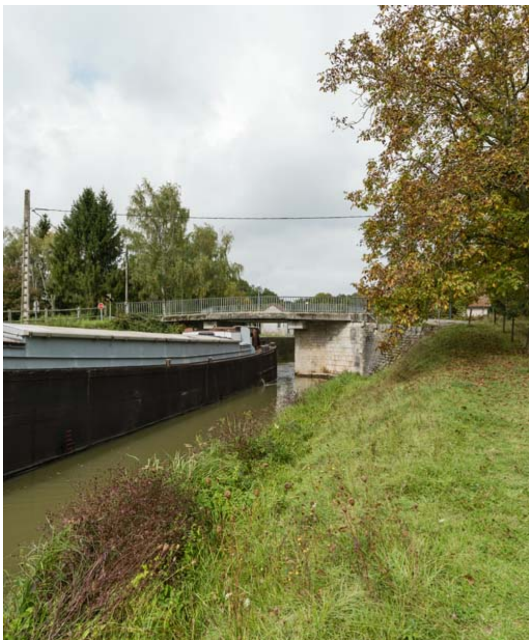
Vue d'ensemble du pont.
