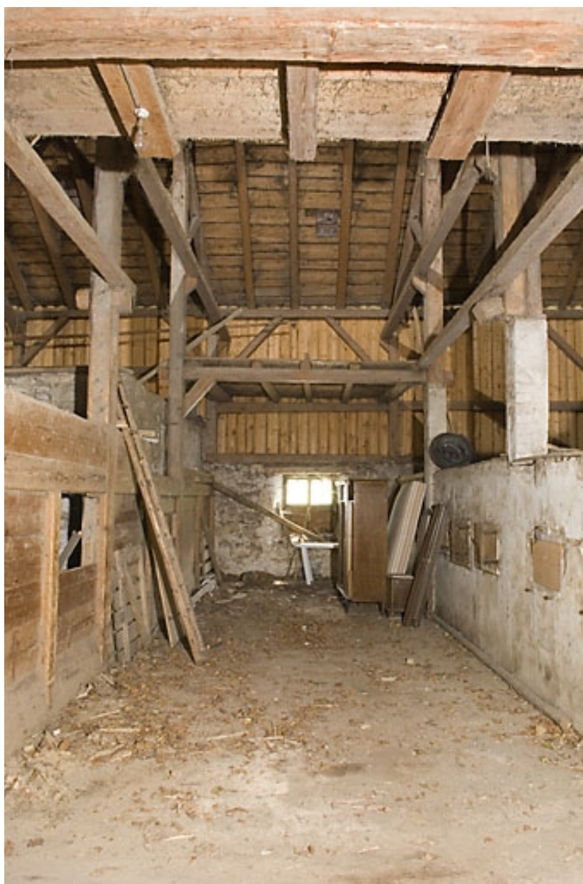
Grange : travée centrale.
