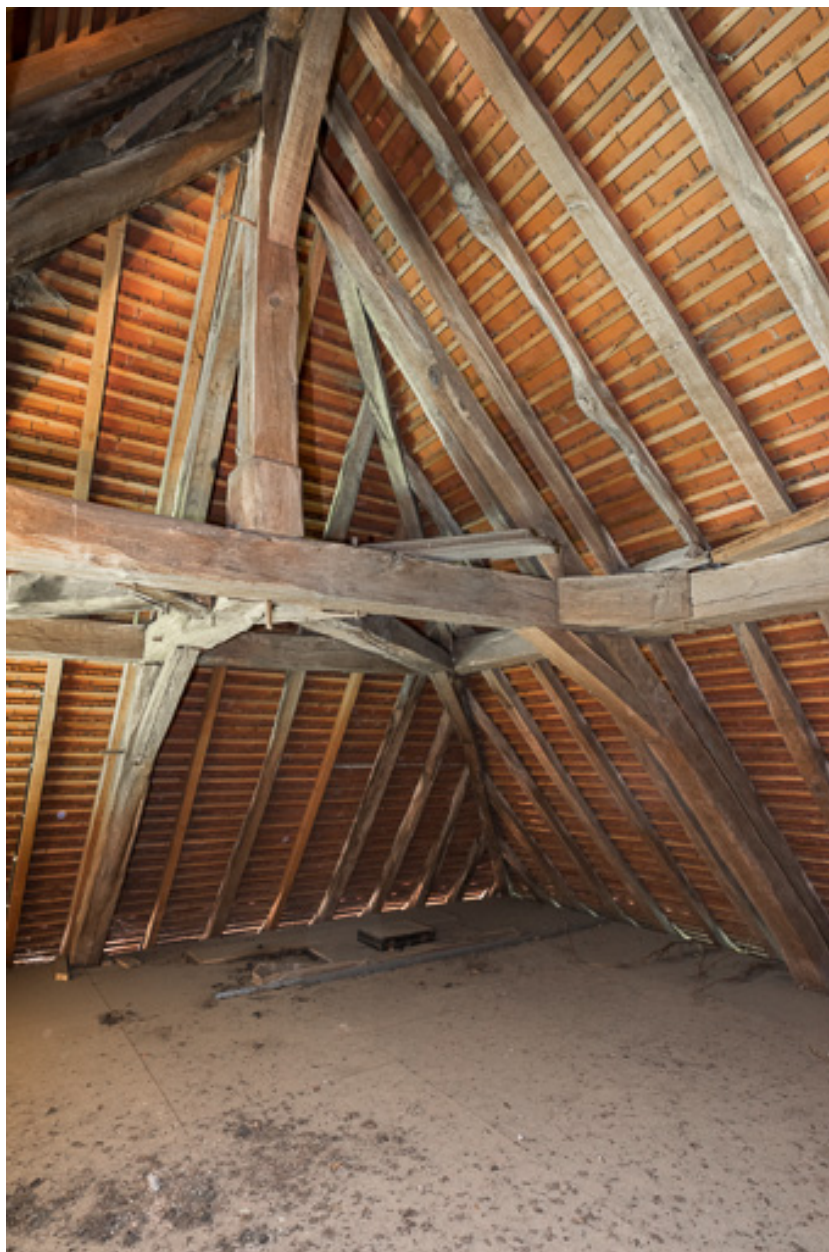
Vue de la charpente du toit à croupes de la maison
