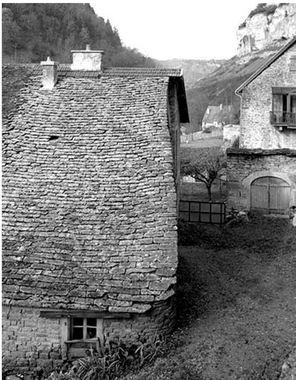
Détail d'une toiture en laves.
