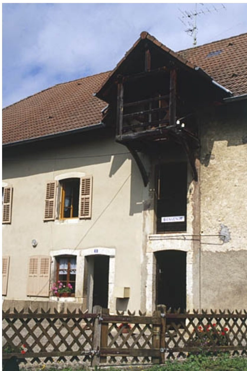
Logement accolé à la minoterie.
