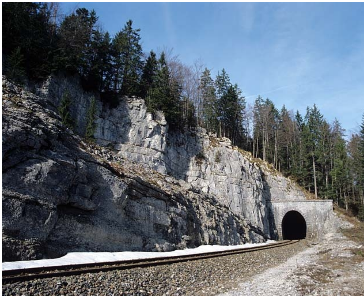
Tête côté La Cluse et paroi rocheuse.
