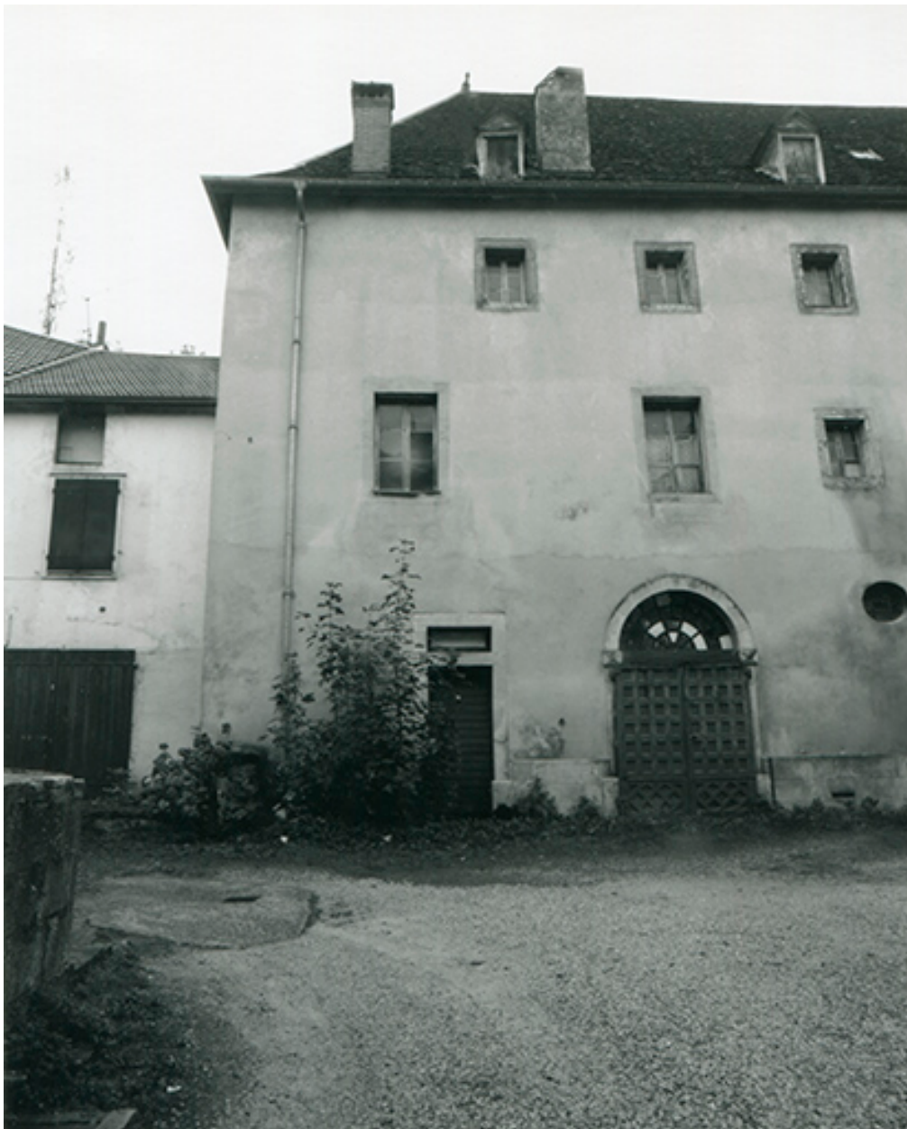
Façade nord du bâtiment conventuel. Travées orientales, 1997.
