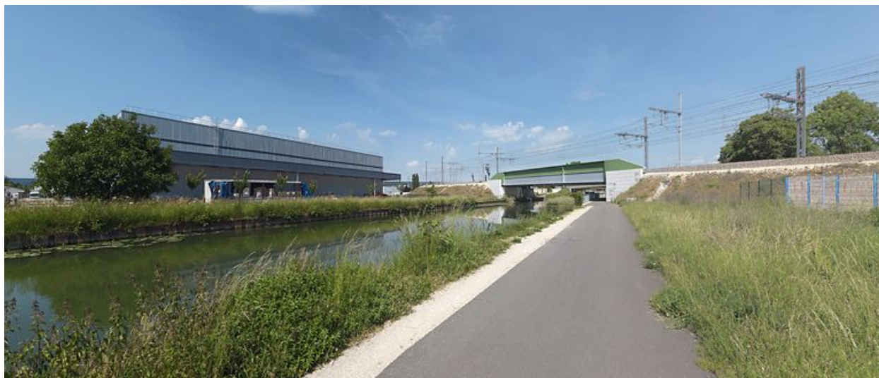
Vue d'ensemble du pont et de son environnement.
